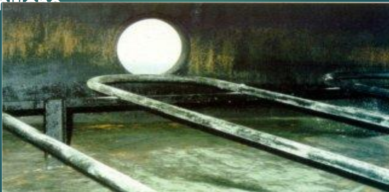
Bonifiche all'interno di un serbatoio
